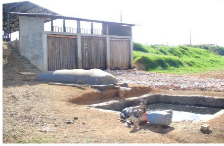
Figura 4: Imagem do biodigestor do setor produtivo bovinocultura IFMG campus Bambuí.
