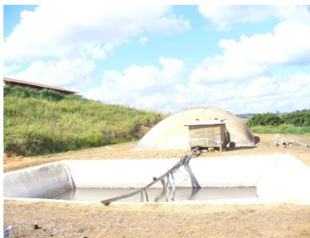
Figura 3: Imagem do biodigestor do setor produtivo suínocultura IFMG campus Bambuí.
